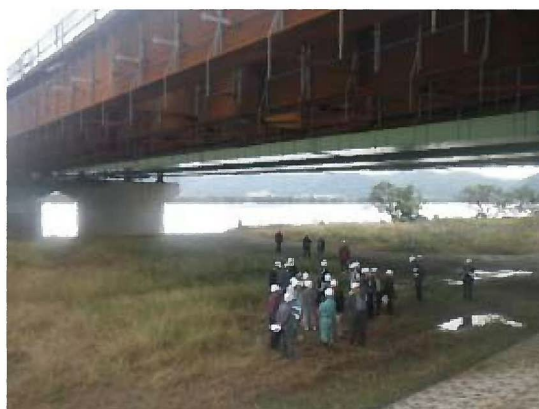
現場説明（横桁、対傾構他構造説明）
