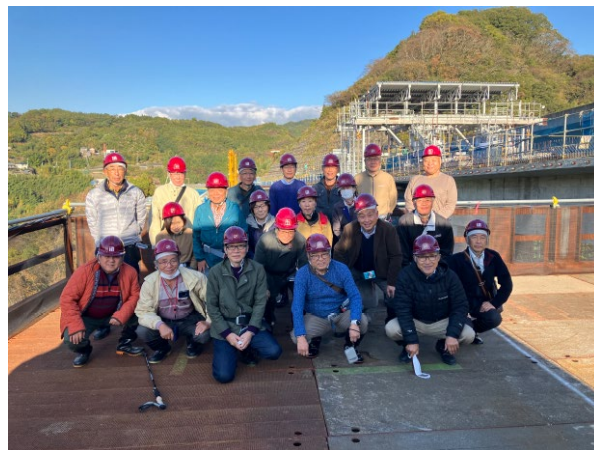
仮設栈橋から橋梁を望む
