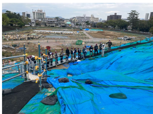
石垣撤去、構造の見学
