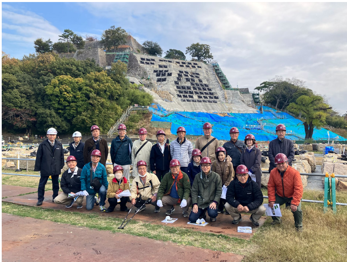
丸亀城石垣復旧整備事業（全景）
