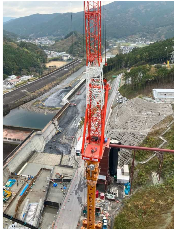
上) 下流側放流設備施工状況 左) 早明浦ダム堤頂での記念撮影
